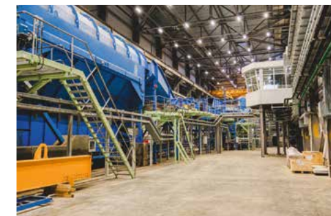
Древесно-подготовительный цех №2 (ДПЦ-2)
