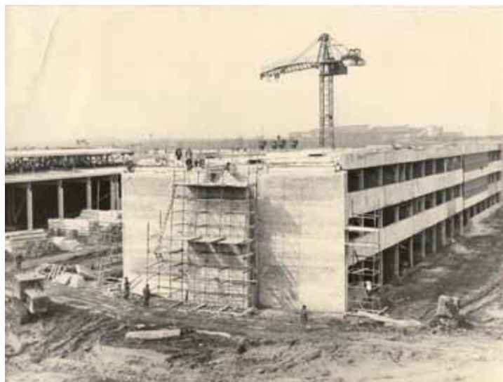
Строительство Железногорского комбината, 1967 год
